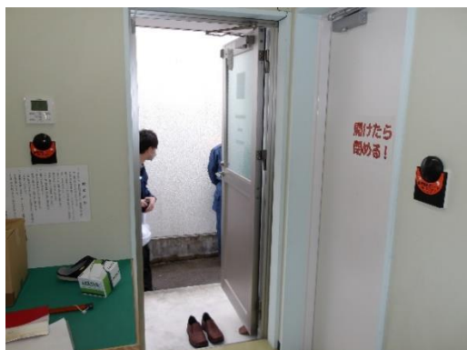
写真 20 出入口 (西) と扉 (壁) (調査時)
