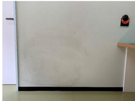
写真 17 壁面の状態 (調査時)
