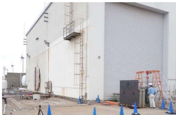
真空燃焼試験棟(燃焼前)
