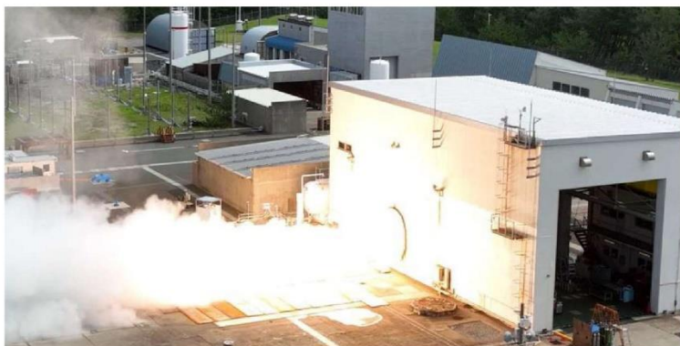
異常発生直前(南側)
