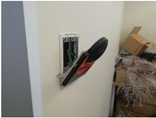
写真 14 静電気除去シート (記録画像)
