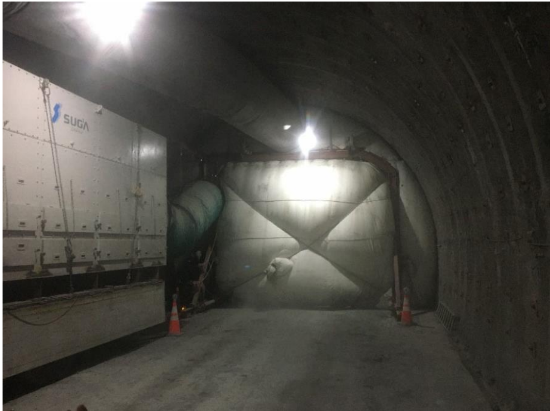
写真3 防塵用カーテン稼働状況
