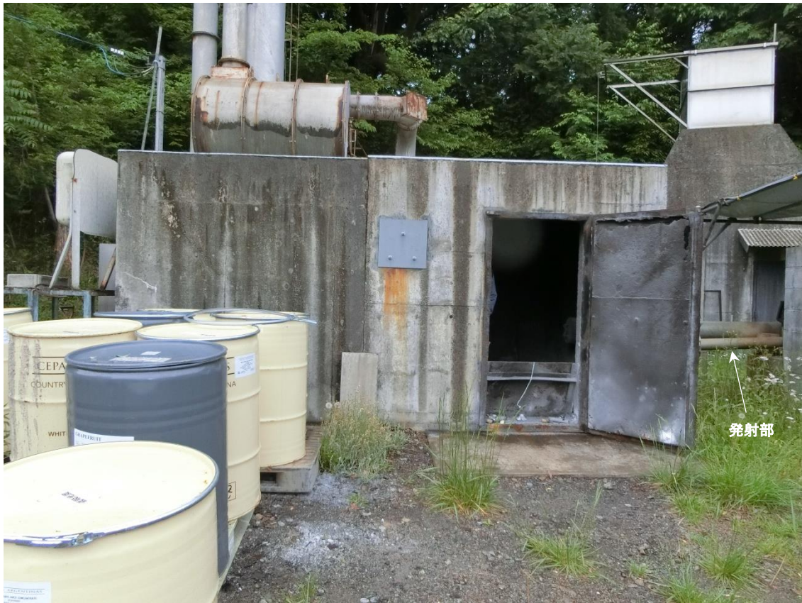
図 3 第 1 試験場 (全体が鉄筋コンクリートで覆われている。)
