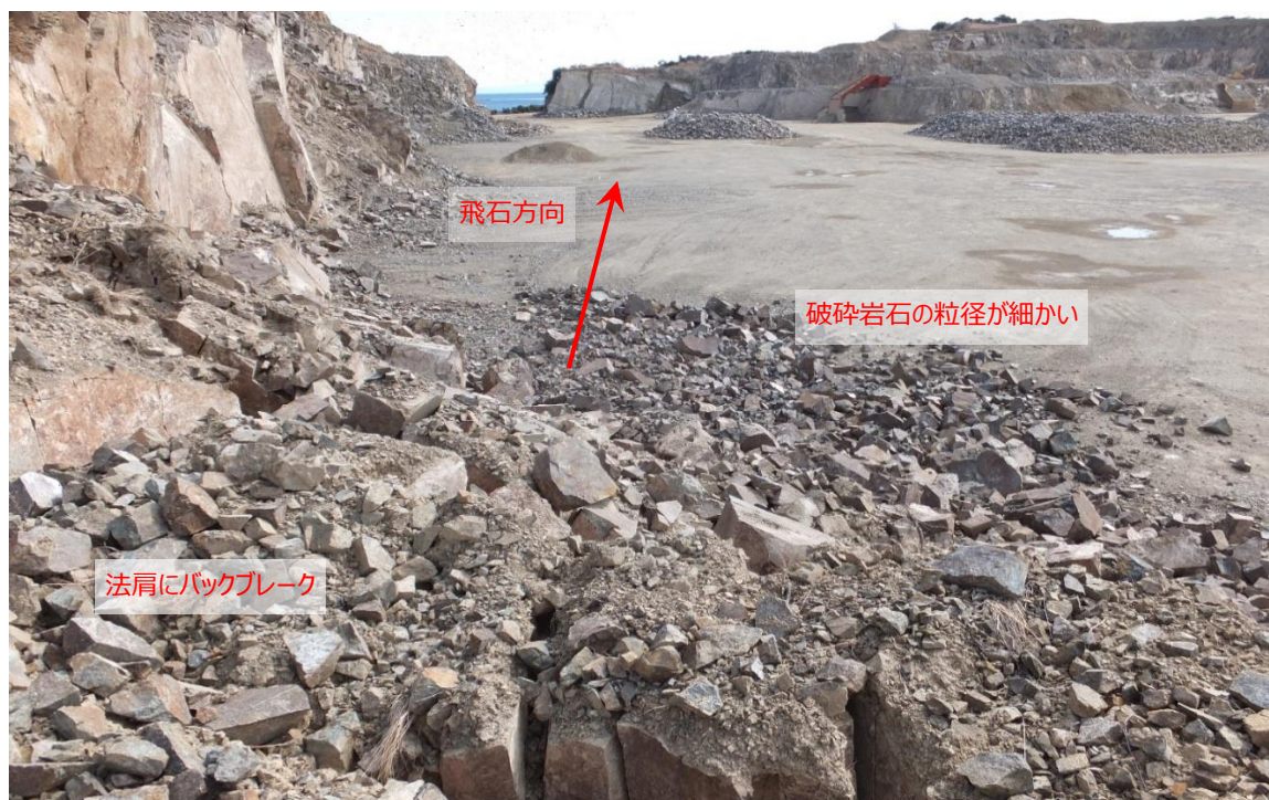
写真4 発破後の状況
