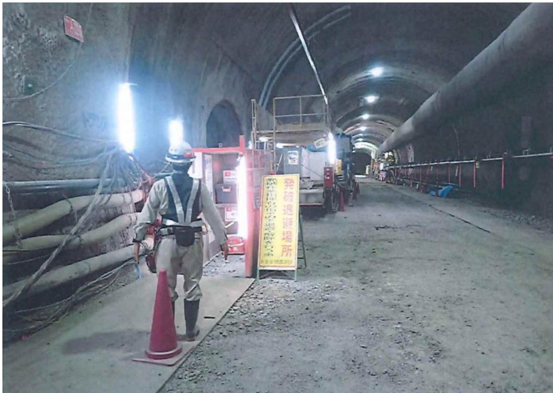
写真1 点火小屋及びその後方の退避場所状況
