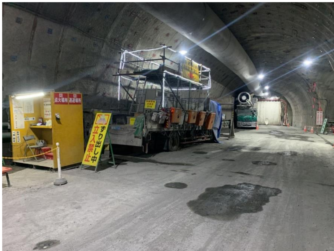
写真1 点火退避場所（坑口側より）
