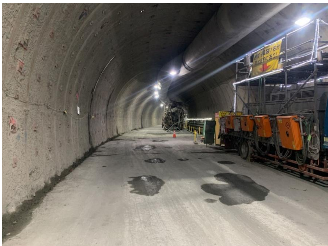
写真2 点火退避場所（切羽側より）
