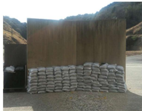
ボックスカルバート後方に L型擁壁+土嚢設置
